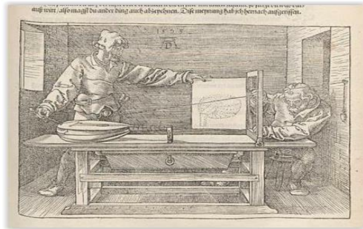
Fig. 15. La machine à dessiner de Dürer , vue 182 Instruction sur la manière de mesurer , 1525, Albrecht Dürer, ou encore fenêtre ou portillon de Dürer.
