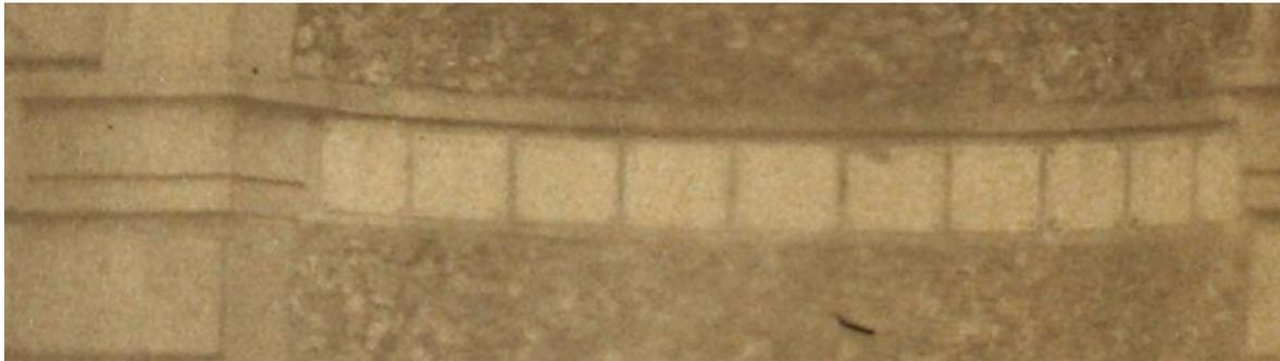
Fig. 10. Zoom de la figure 9, les plaques sont encore entières en général
