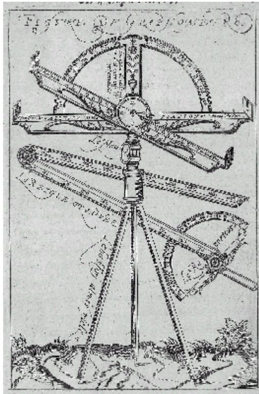
FIG. 2 : Le graphomètre de DANFRIE, *Déclaration de l'Usage du graphomètre*, 1597
